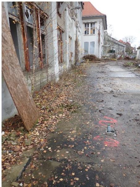
Bild 3-5 Auf der linken Seite befindet sich das marode Gebäude, welches abgerissen werden soll und im Hintergrund das denkmalgeschützte Gebäude.
