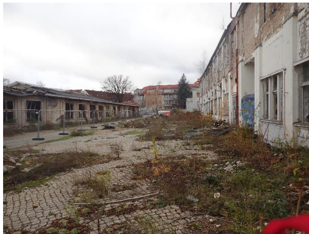
Bild 3-3 Denkmalgeschützte Pflastersteine im Vordergrund, auf der rechten Seite befindet sich das rückzubauende Gebäude, auf der linken Seite hinter dem Bauzaun das Nachbarbaufeld (Kindertagesstätte und Sonstige Soziale Infrastruktur) und im Hintergrund das denkmalgeschützte Gebäude.
